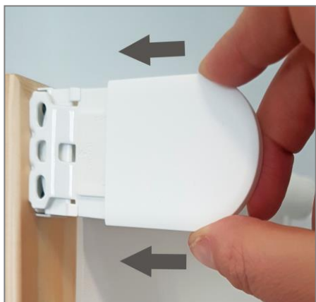
7. Abschließend die PVC-Abdeckkappe auf den Träger schieben
